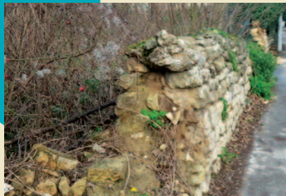
Le mur avant le début des travaux
