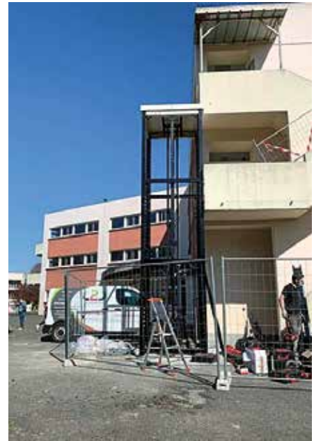
Création d'un ascenseur pour Personnes à Mobilité Réduite à l'école Marcel Pagnol
