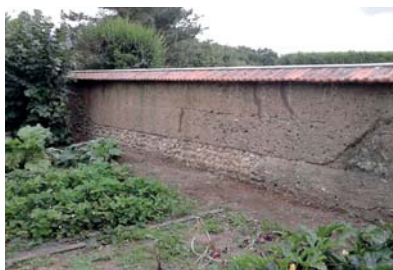
Mur de clôture en pisé
