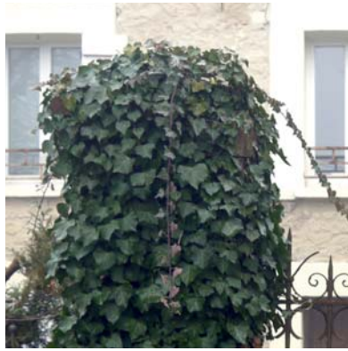
Dévégétaliser les piles et murets
