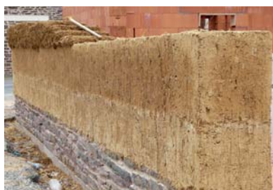
Mur en bauge en cours de construction
