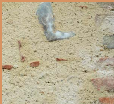
Enduit à pierre vue brossé avant séchage complet
