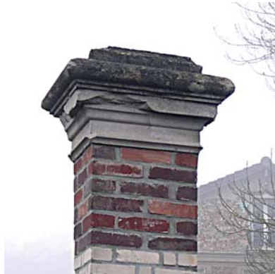
Réparer les corniches et autres décors
