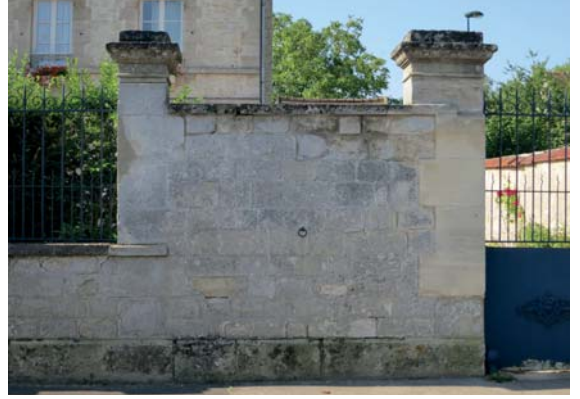
Des pierres d'angles pour chaque ouverture, ici à Orry-la-Ville
