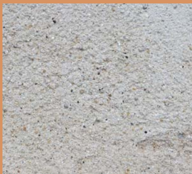
Enduit couvrant à texture grossière
