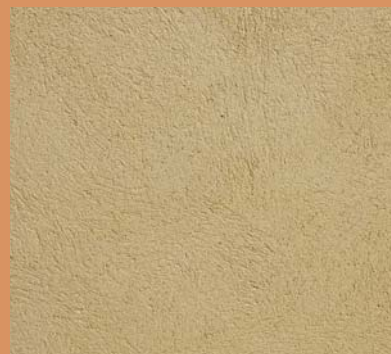
Enduit couvrant lissé à la taloche en bois
