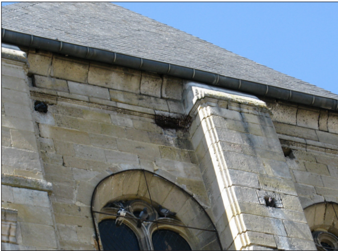
Présence de volatiles dans les trous de boulin - Déjointement de la corniche
