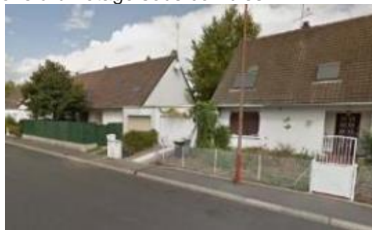
Maisons mitoyennes par le garage, rue des prés à l'ogre
