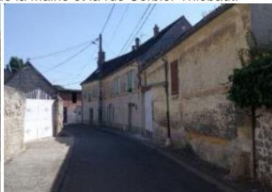
Anciens corps de ferme, rue Thiers
