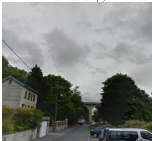
• Vue sur le viaduc depuis la rue du viaduc (4)
