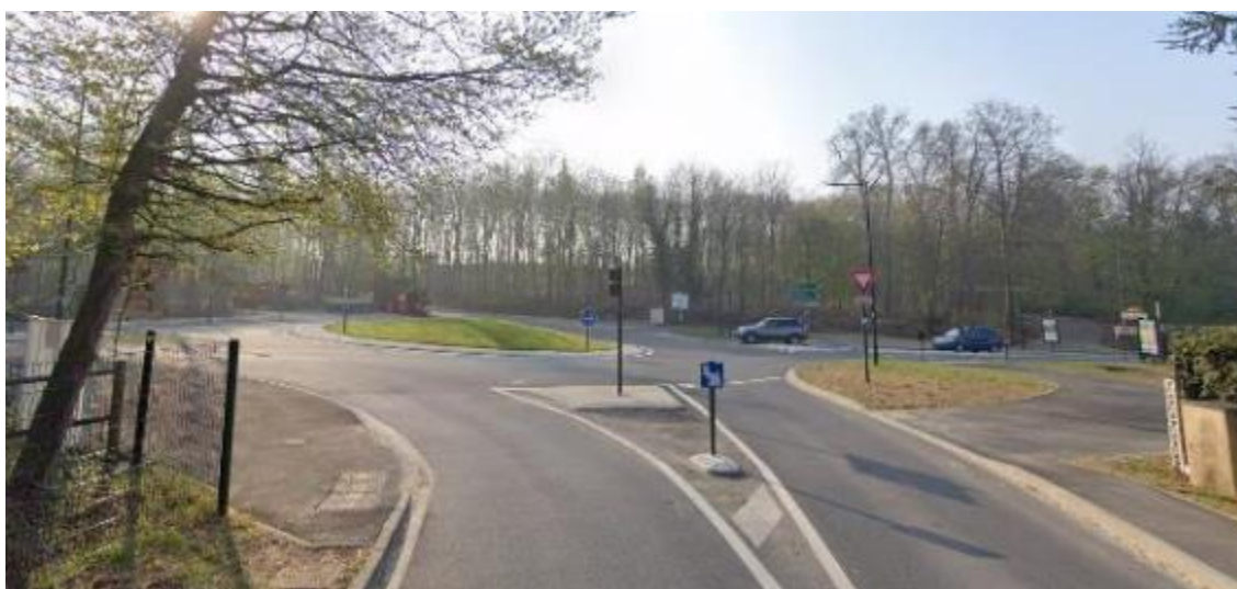
Avant/Après des travaux sur la RD1016
